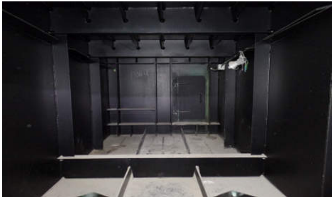
강박스 내부 전경
